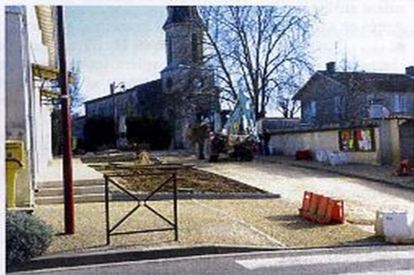
Les travaux en cours ont pour but une mise en valeur de la Mairie afin d'assurer une meilleure visibilité depuis la voie publique par l'affirmation de son caractère d'édifice public.
