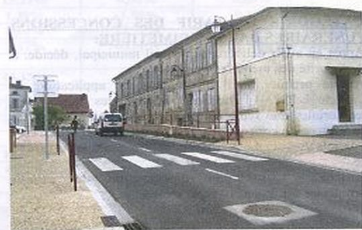
Les travaux d'aménagement de Bourg vont se poursuivre en 2008
