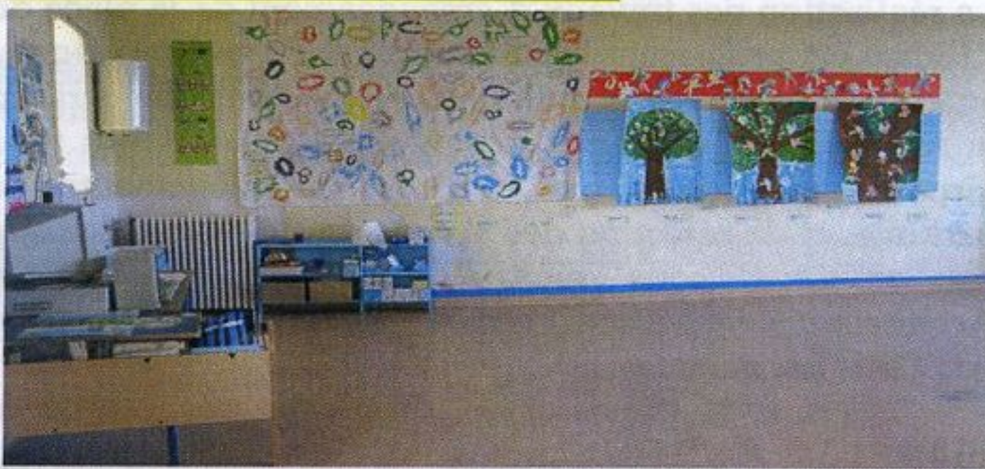
Dans le dortoir des plus petits, l'entreprise S.P.F.G. a posé un revêtement PVC sur l'ancien parquet (Coût : 4 671.76€)
