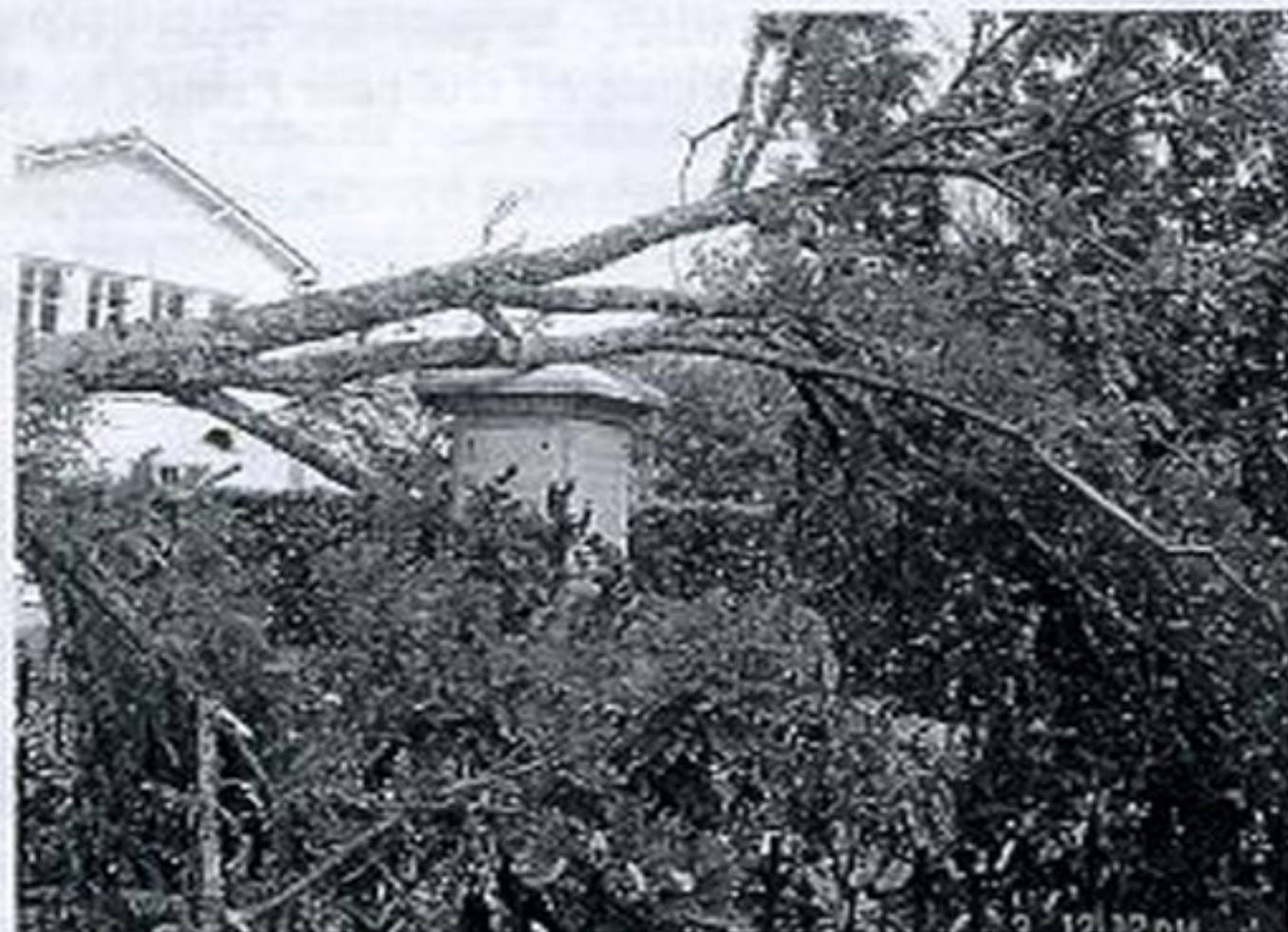
L'obélisque du monument aux morts a été cassée par la chute d'une branche d'acacia.
